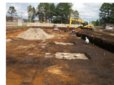
(1. 3Mに掘っている作業)
